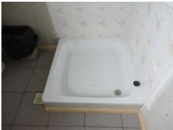
Inspección de terminaciones interiores
