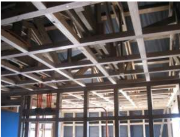
Estructura de muros y cielo
