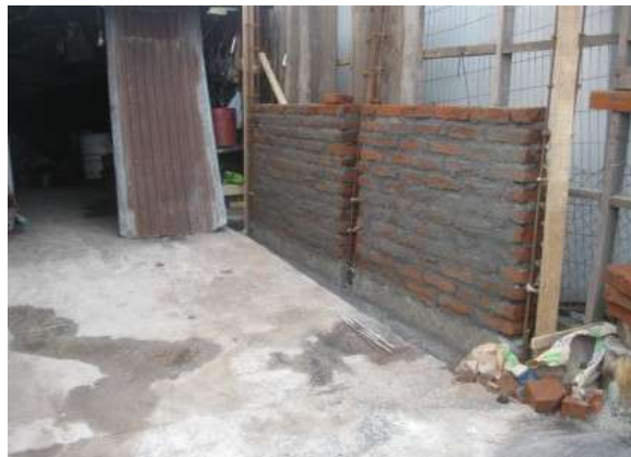
Construcción de muro cortafuego
