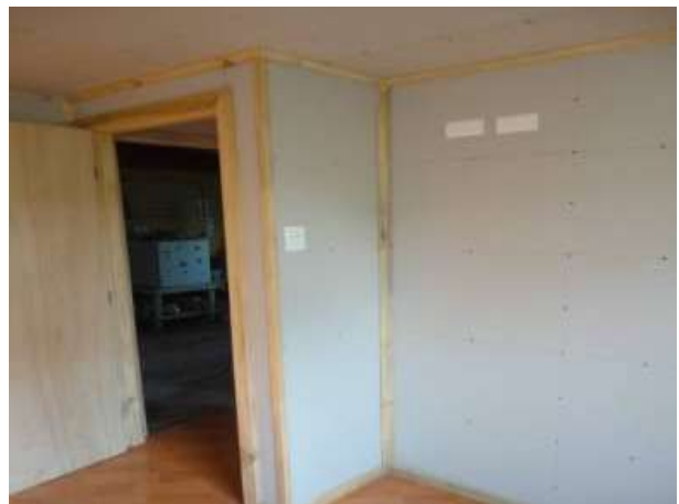
Inspección de terminaciones interiores
