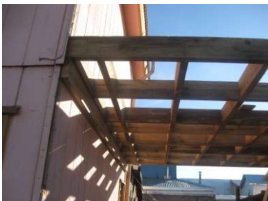
Envigado de piso
