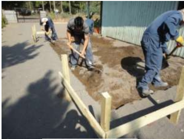
Trazado, nivel y excavación
