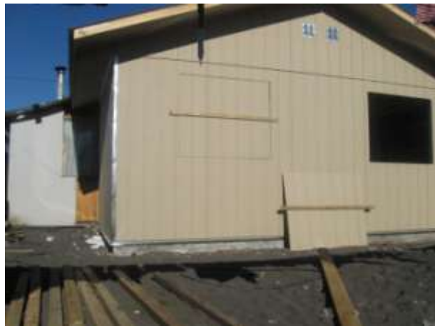
Revestimiento exterior de la ampliación
